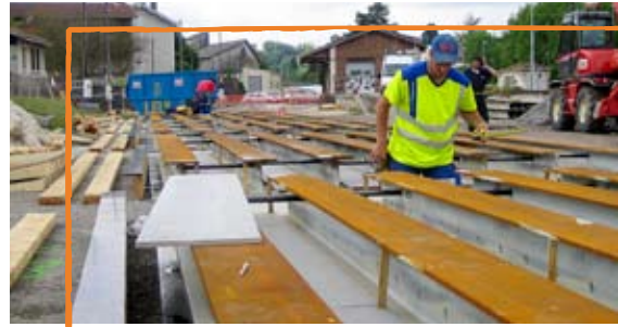
Les poutrelles métalliques sont alignées sur la plate-forme de préfabrication.
