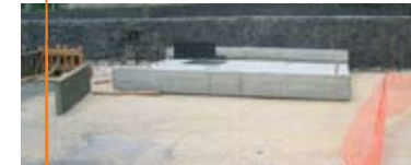
...on démolit ! Et voici un beau tablier en béton armé.
