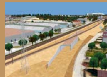
Sept. 2008 – été 2009 : - terrassement, - voie Grenoble-Lyon sur l'ouvrage.
