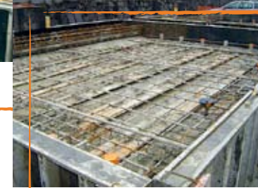
Pour lier poutrelles et armature, le béton est coulé dans le coffrage.
