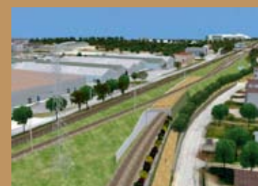
Été 2009 : - 2 e voie Valence-Grenoble sous l'ouvrage, - reprise des quais en gares, - piste cyclable, - protections acoustiques.
