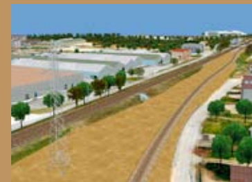
Terrassement mi-2007 – oct. 2007 : - construction mur de soutènement rue de la Coste, - dépose et ripage de la voie.
