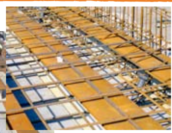
Le ferrailage consiste ensuite à « armaturer » l'ouvrage à l'aide de tiges et crosses en acier.
