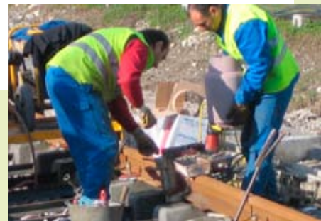
Les invités ont assisté à la soudure d'un rail sur la nouvelle voie Grenoble-Montmélian.
