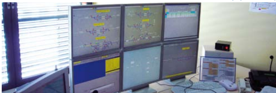
Pour exemple, les écrans de contrôle du PCD d'Annemasse mis en service en janvier 2007 (premier poste en France équipé de tableaux de contrôle optique sur écrans).
