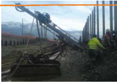
Les équipes procèdent ensuite à l'ancrage de tiges métalliques complémentaires.
