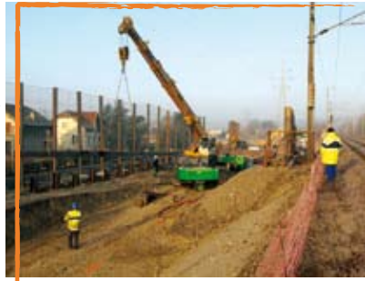
Dernière opération pour renforcer la solidité du blindage : la pose de « liernes » que l'on voit ici levées par une grue.
